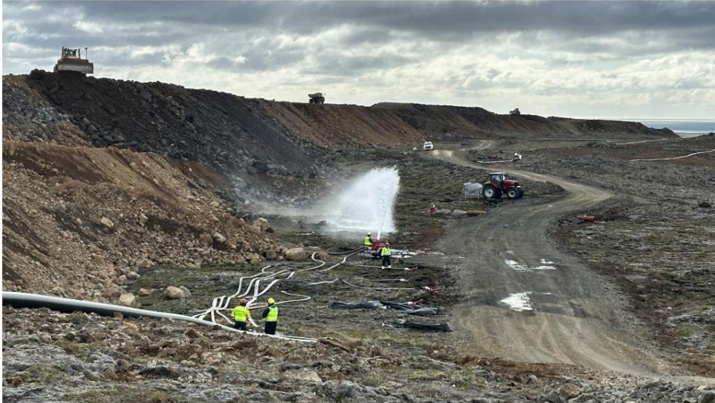
Abbildung 5. Bau von Deichen und Tests von Lavakühlgeräten.
